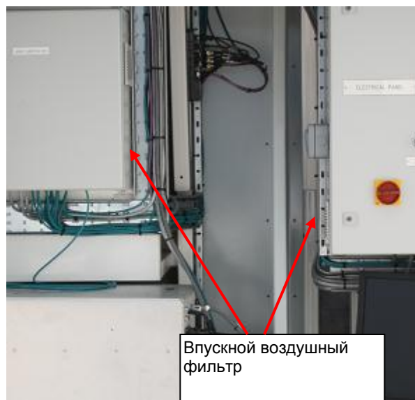
Рисунок 7-1. Расположение впускного воздушного фильтра
