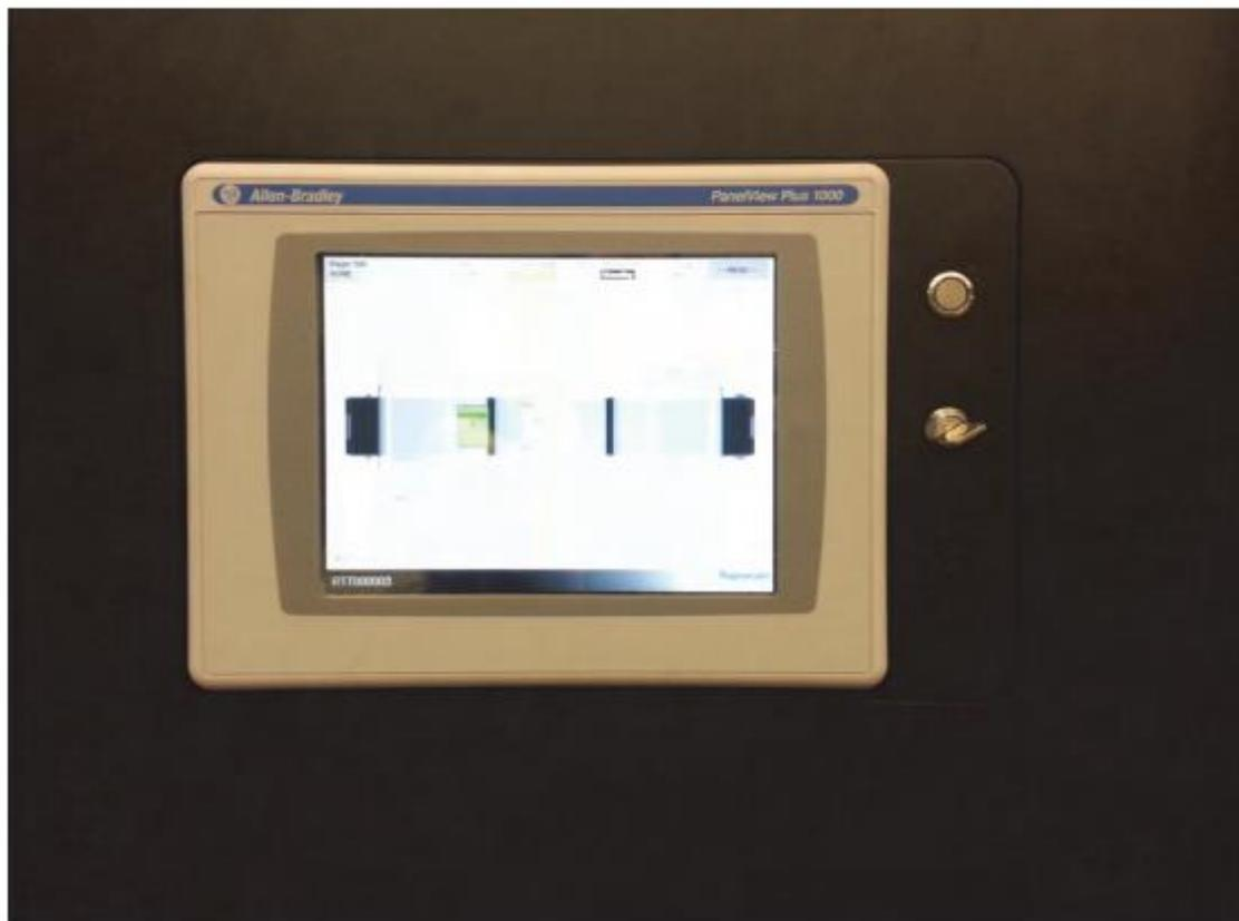
*Рисунок 4 Функции безопасности RTT110, Автоматизированное рабочее место (АРМ), и ключевой пусковой переключатель*
