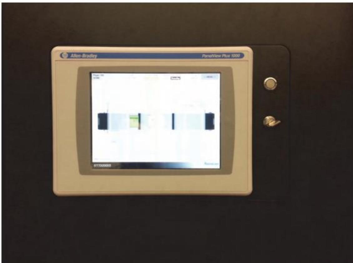
*Рисунок 21 дисплей АРМ, Главный переключатель и Кнопка перезапуска
