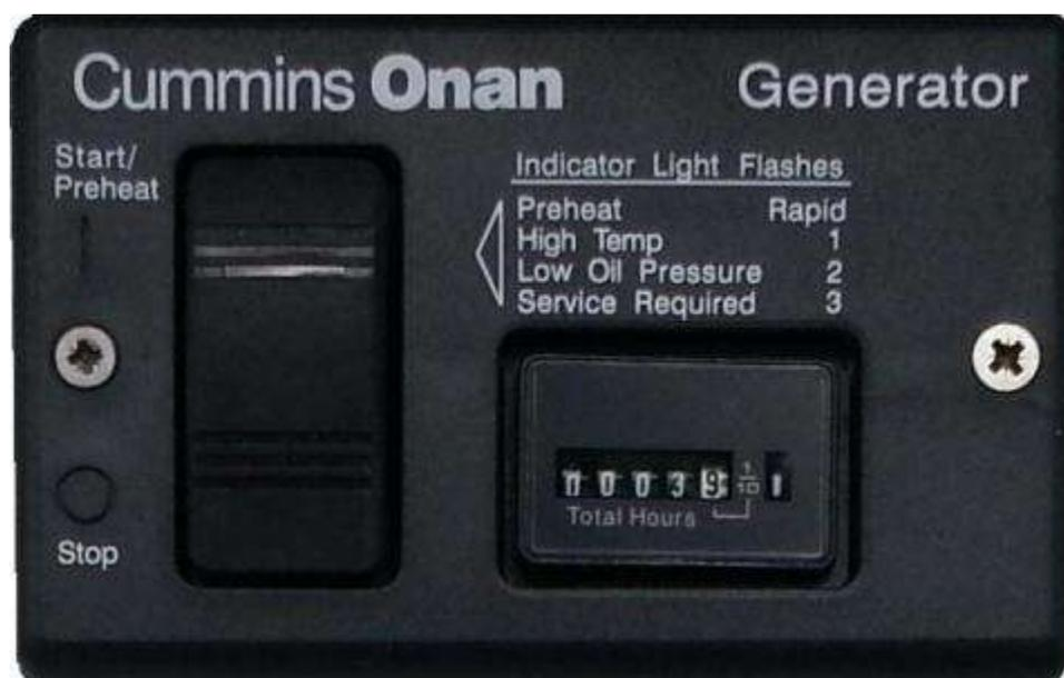
Рисунок 4-6 Панель удаленного управления генератором
