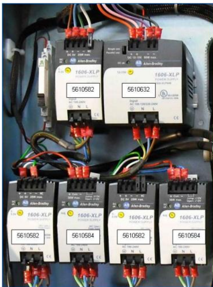
Рисунок 9-16: Источники питания в корпусе (6)
