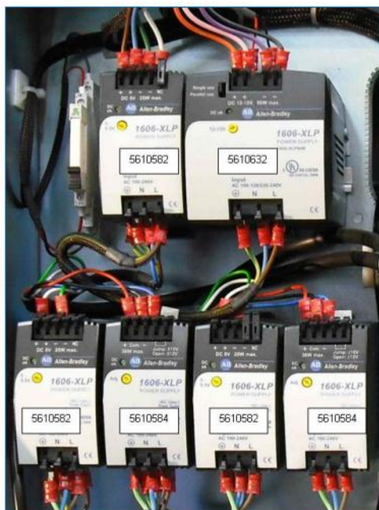
Рисунок 7-8: Источники питания в корпусе
