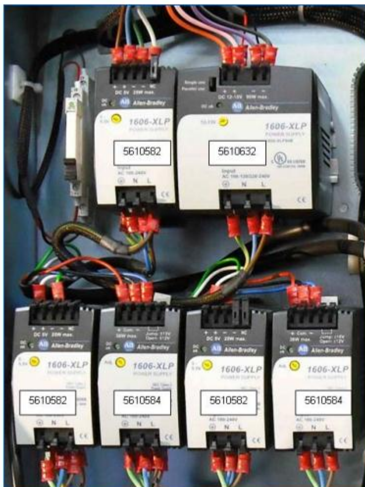
Рисунок 8-7: Источники питания в корпусе (6)
